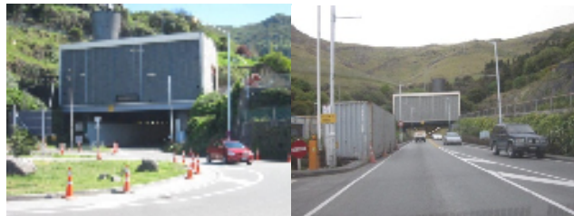
リトルトンとクライストチャーチを結ぶトンネル。左がリトルトン側、右がクライストチャーチ側。長さ約 2km
