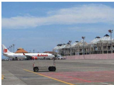
新ターミナル建設中のバリ・デンパ サル空港
